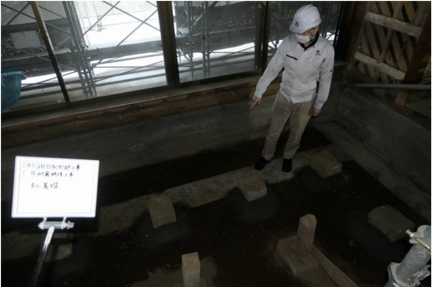
上屋1階 庭側の鉄骨基礎部分です。
