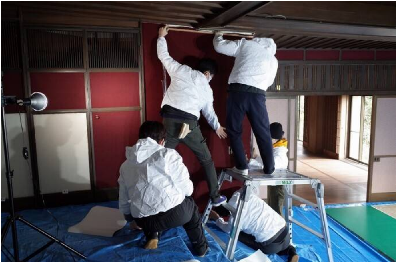
地下室 雑工事 貼り壁補修 上貼り
