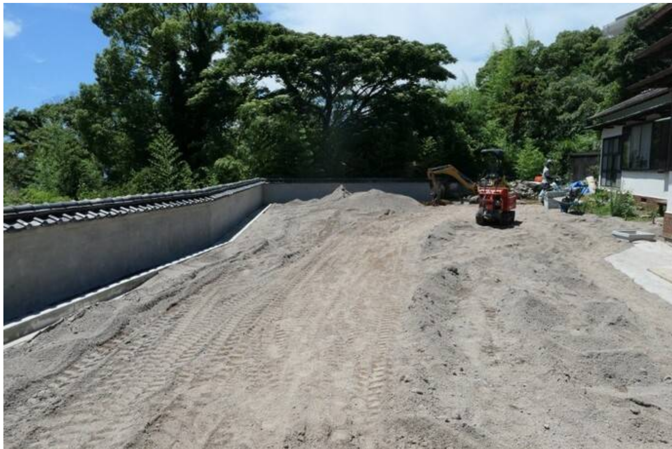
宅地 復旧工事 軽量土搬入
