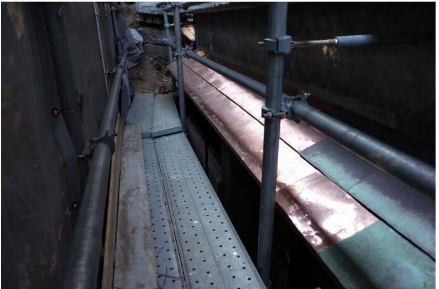
地下室 屋根工事 西庇葺替え完了
