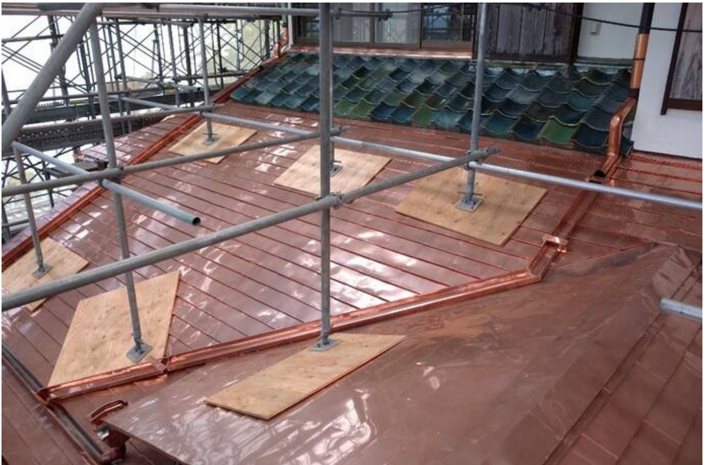
附上屋 屋根工事 銅板葺きと樋工事が完了しました。 当初の銅樋のうち、可能なものは補修し再利用しました。
