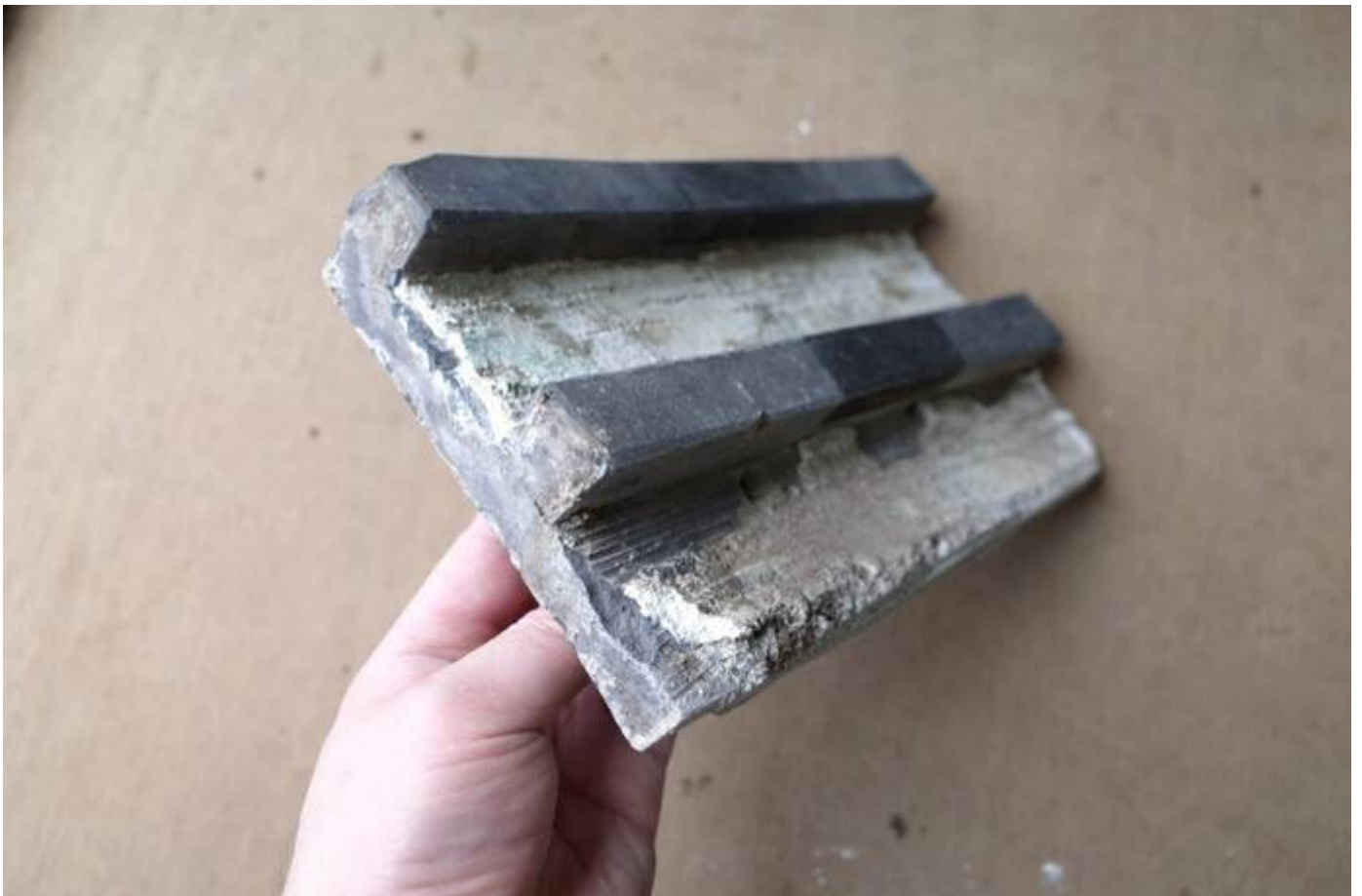
附上屋 RC補修工事 練塀状の瓦
