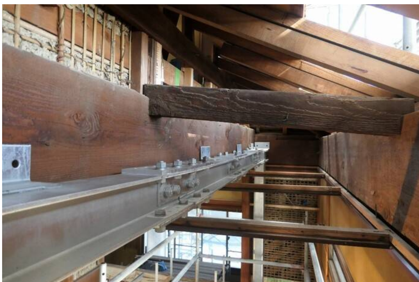
附上屋 耐震補強工事 天井上梁部分 天井部分隠蔽部分になります。 鉄管柱2本及び基礎梁とフレームを組みました。写真左方の木部梁は2階柱筋になります。
