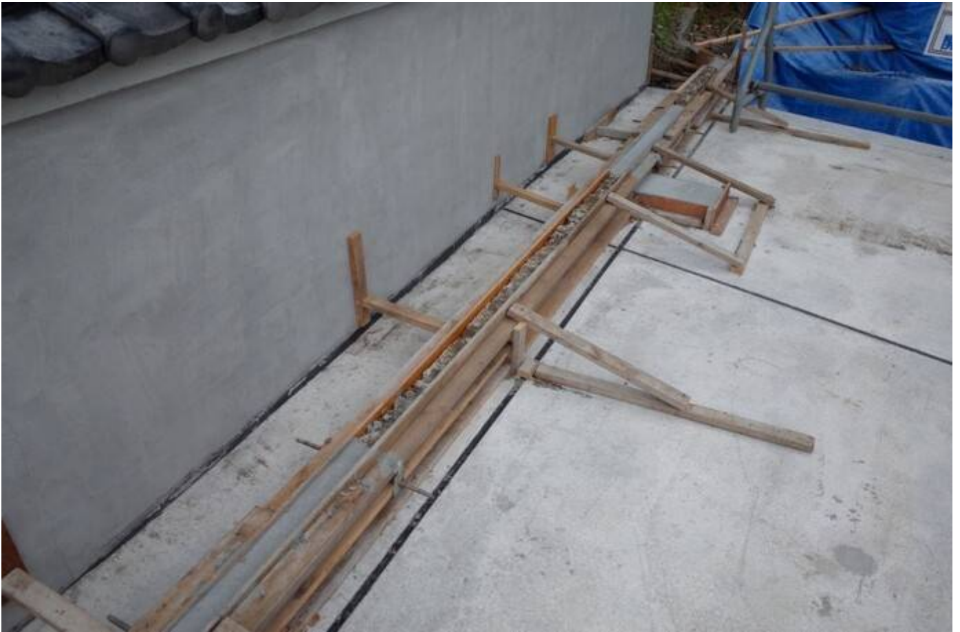
宅地 復旧工事 排水溝復旧 一部既存材を使用。（写真中央部分）
