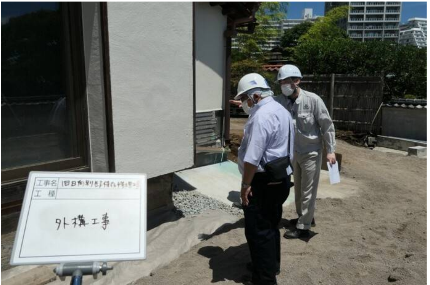
宅地 復旧工事 外構工事
