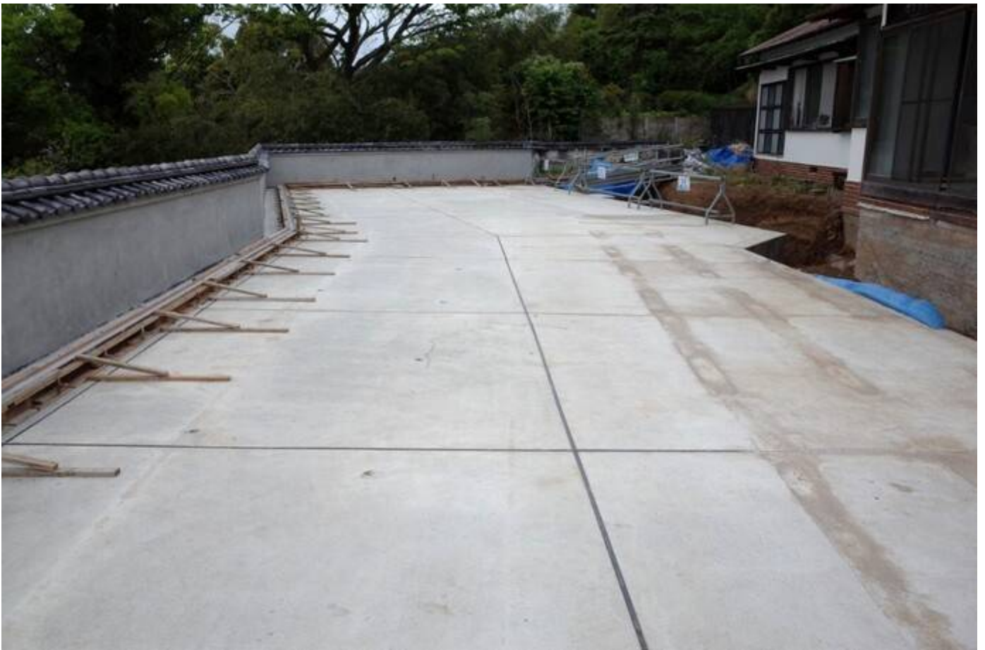
宅地 復旧工事 軽量土敷き均し前
