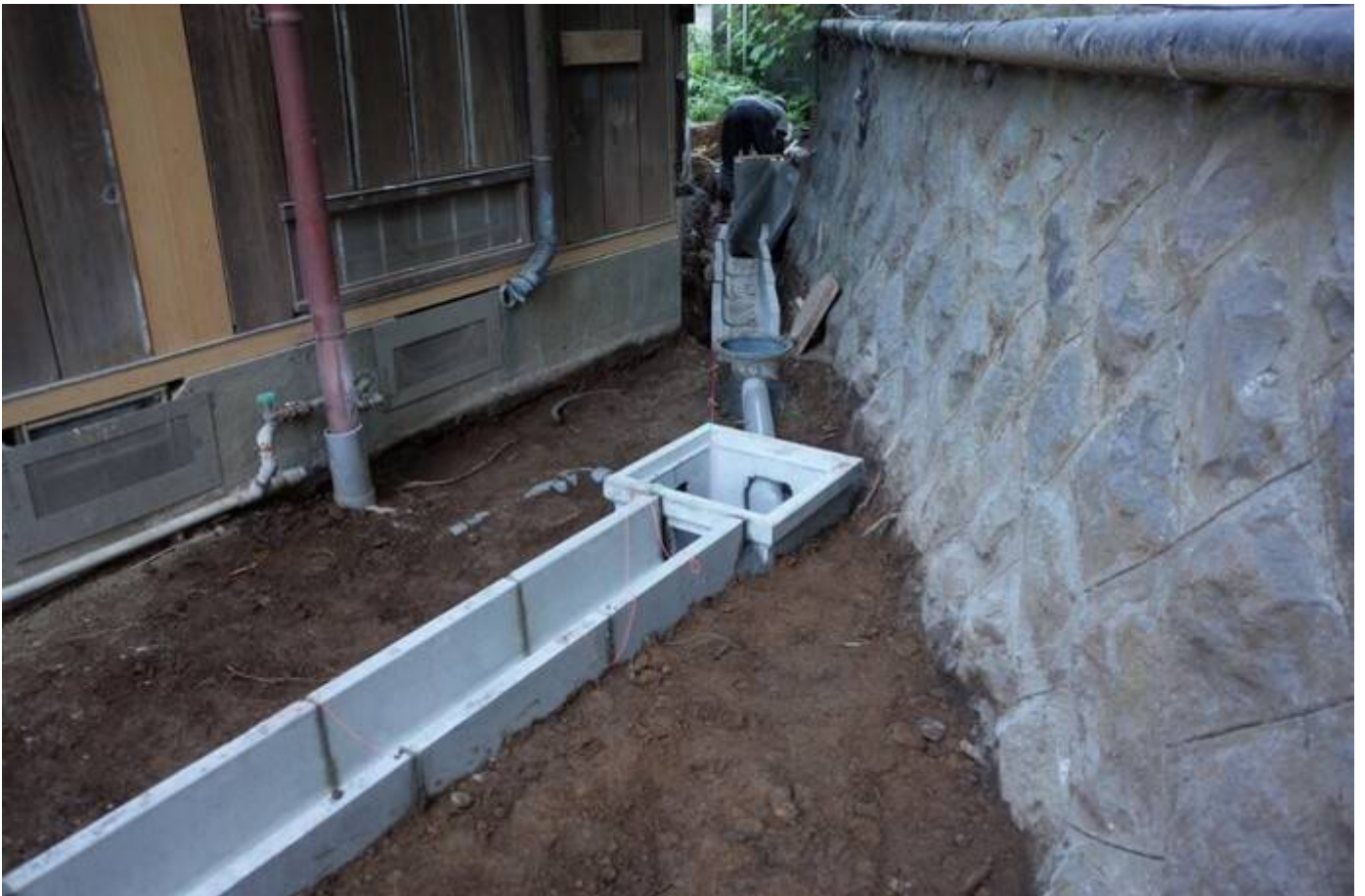
宅地 復旧工事 背面排水溝設置
