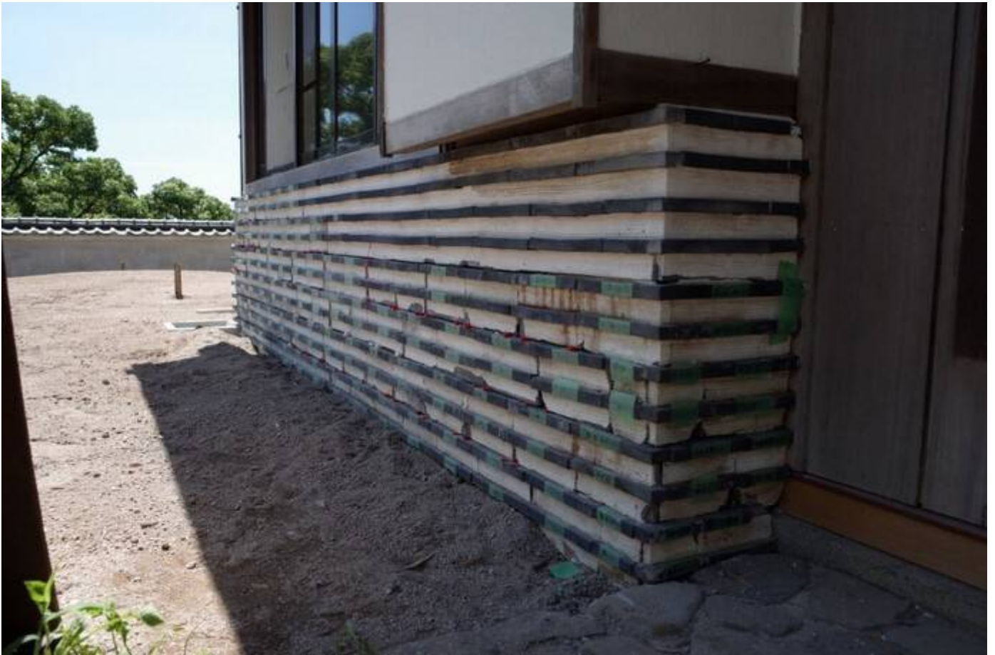
地下室 RC補修工事 階段外部補修
