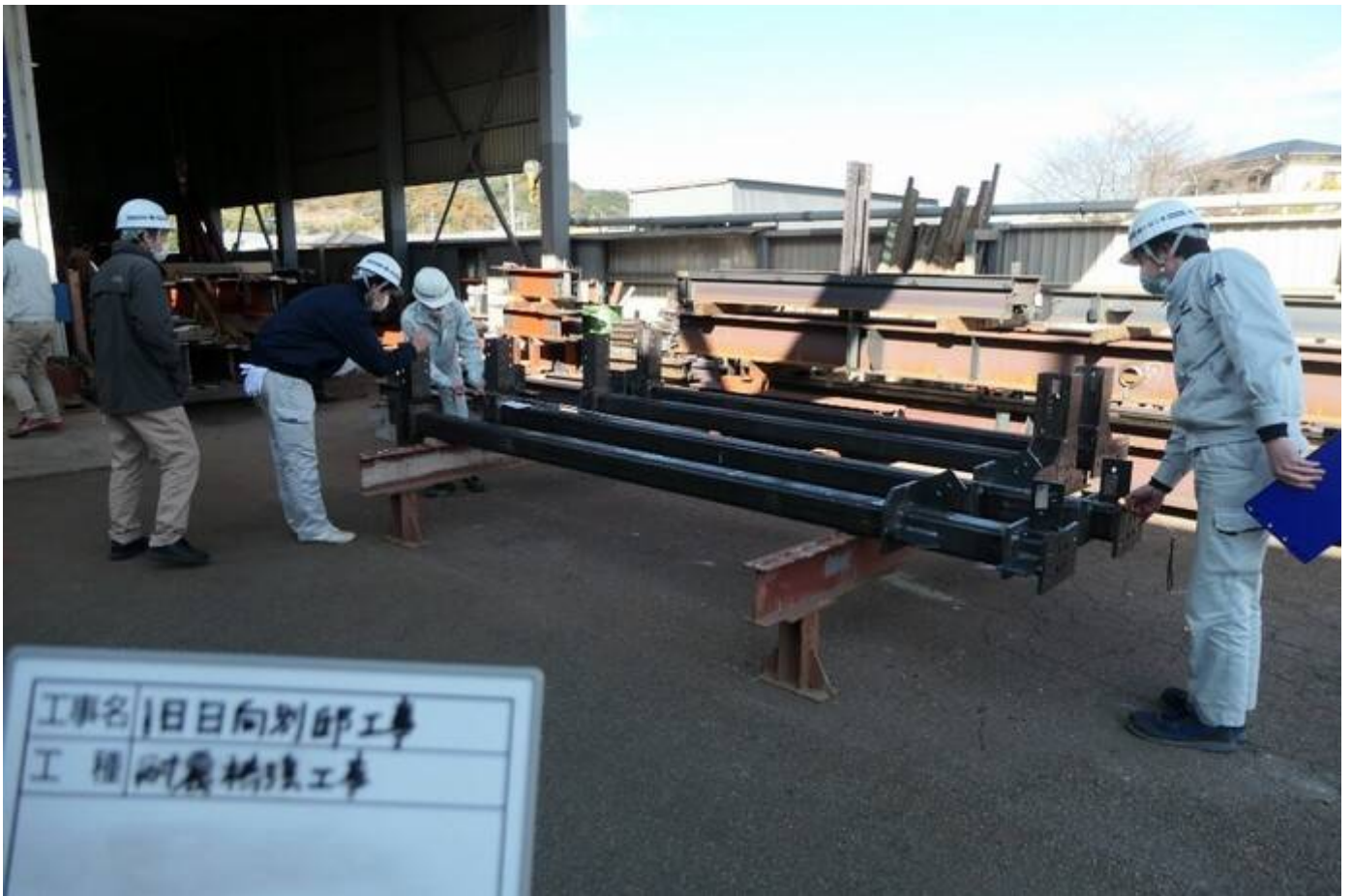
附上屋 耐震補強工事 鉄骨検査 鋼管柱4本
