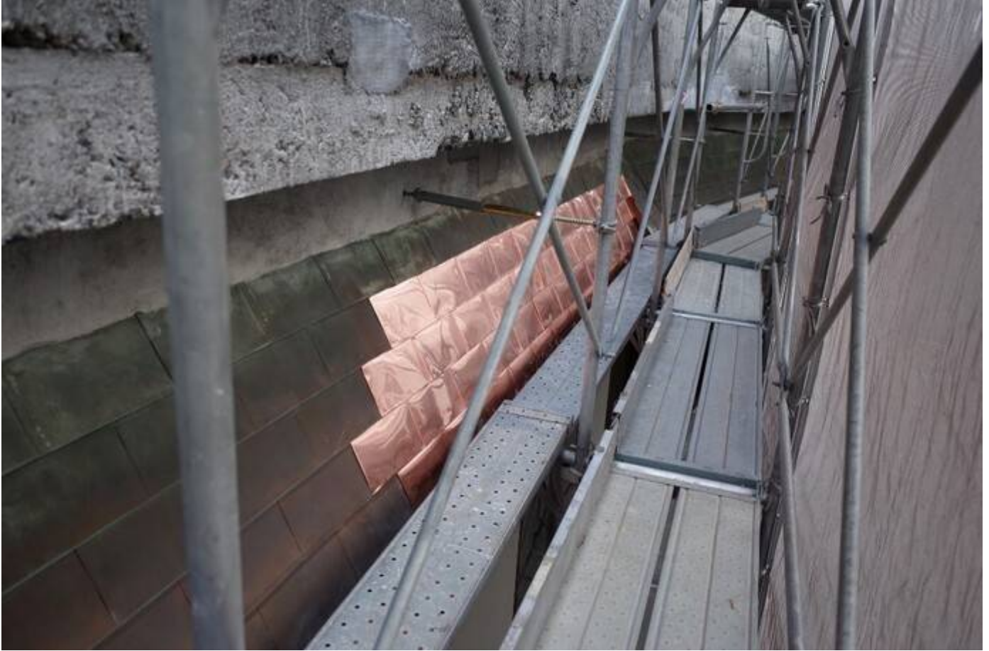
地下室 屋根工事 正面一部葺替え完了
