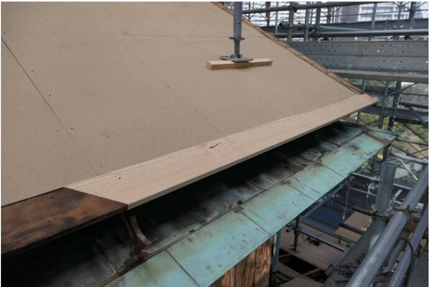
附上屋 屋根工事 木部補修。下地木毛板を張り
