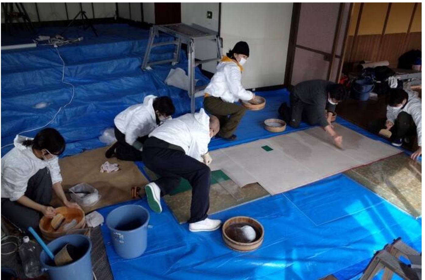
地下室 雑工事 上貼り（糊付け）作業中
