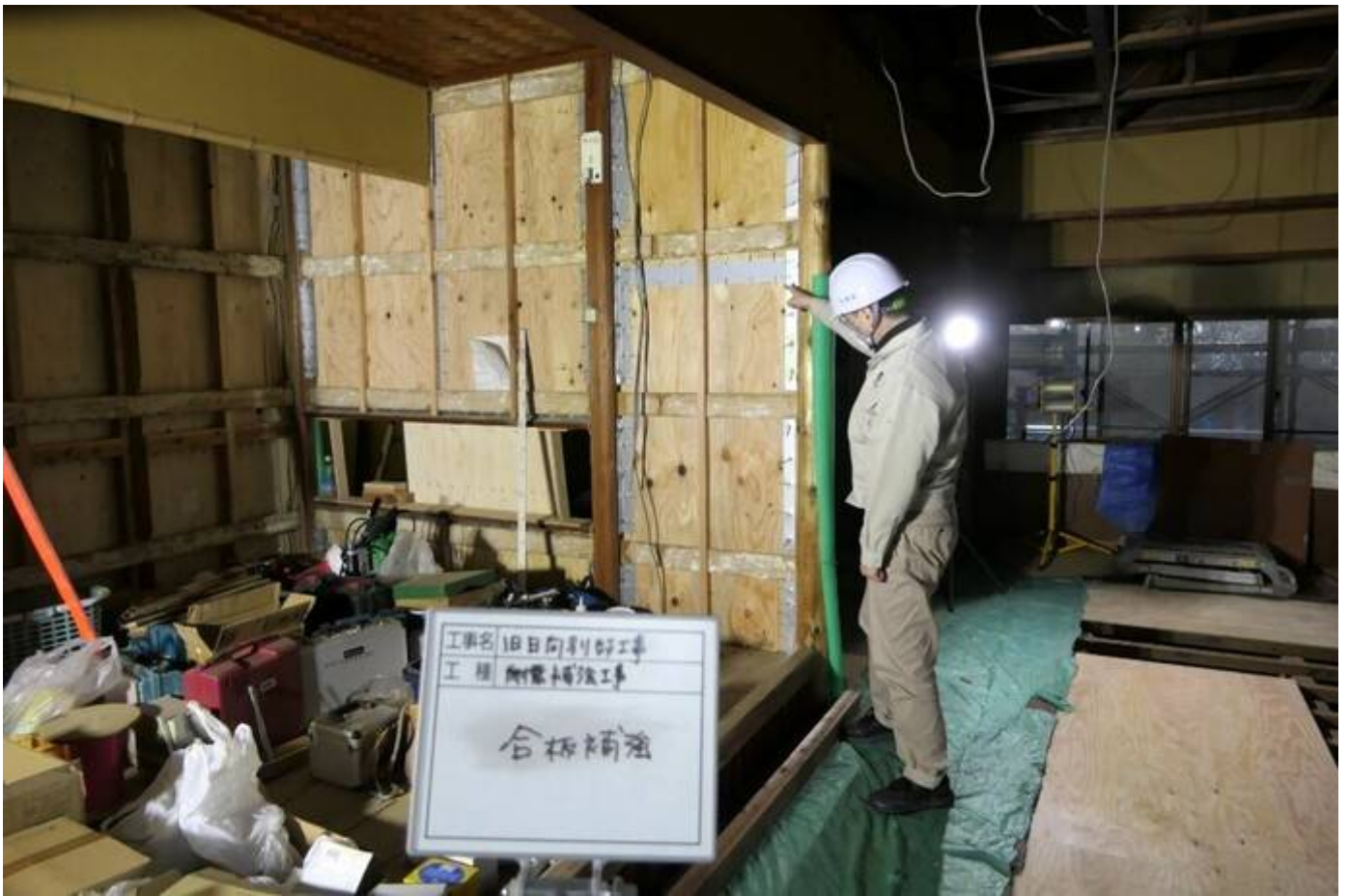
附上屋 耐震補強工事 補強壁工事確認
