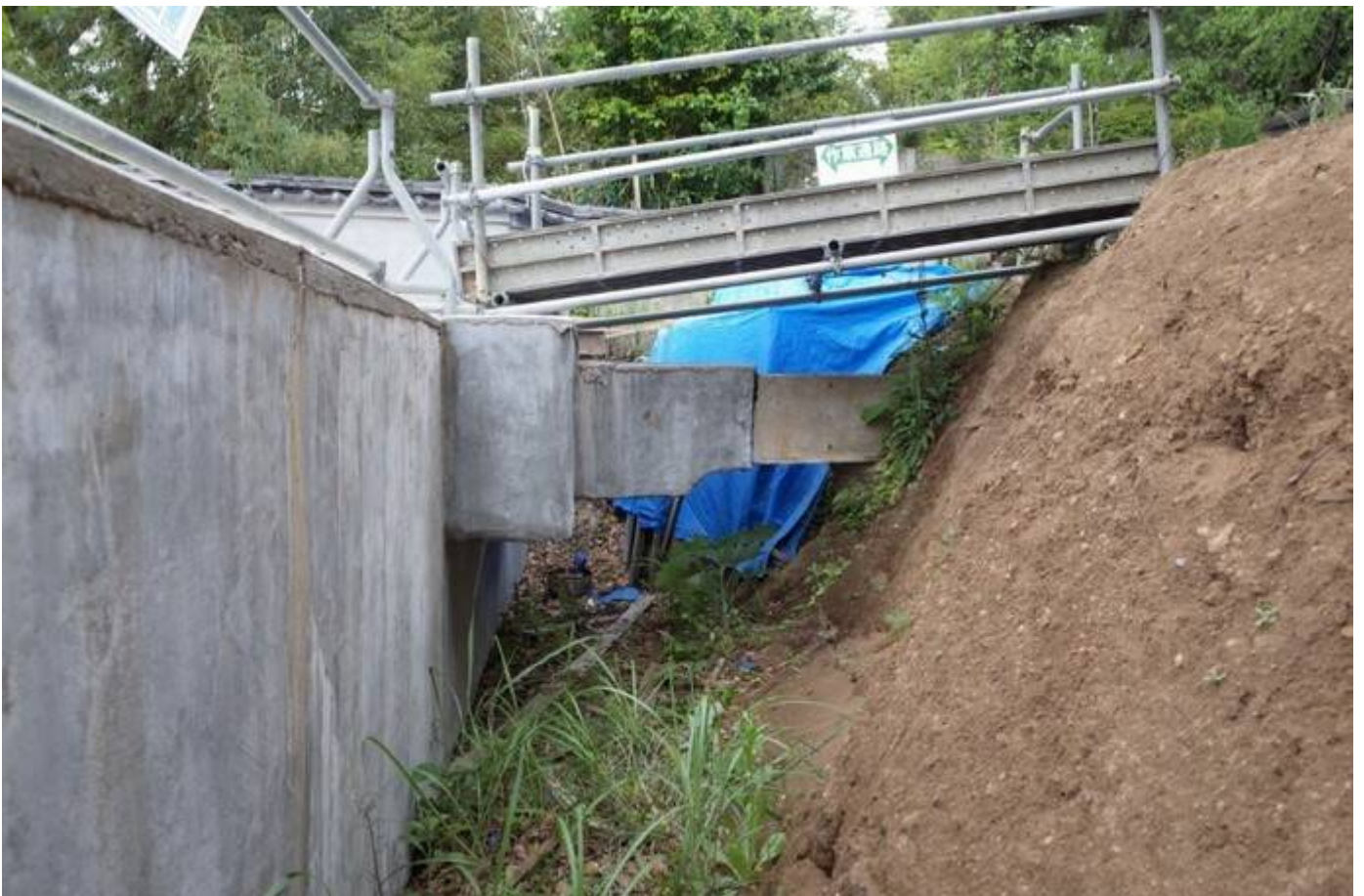
宅地 復旧工事 排水溝設置前
