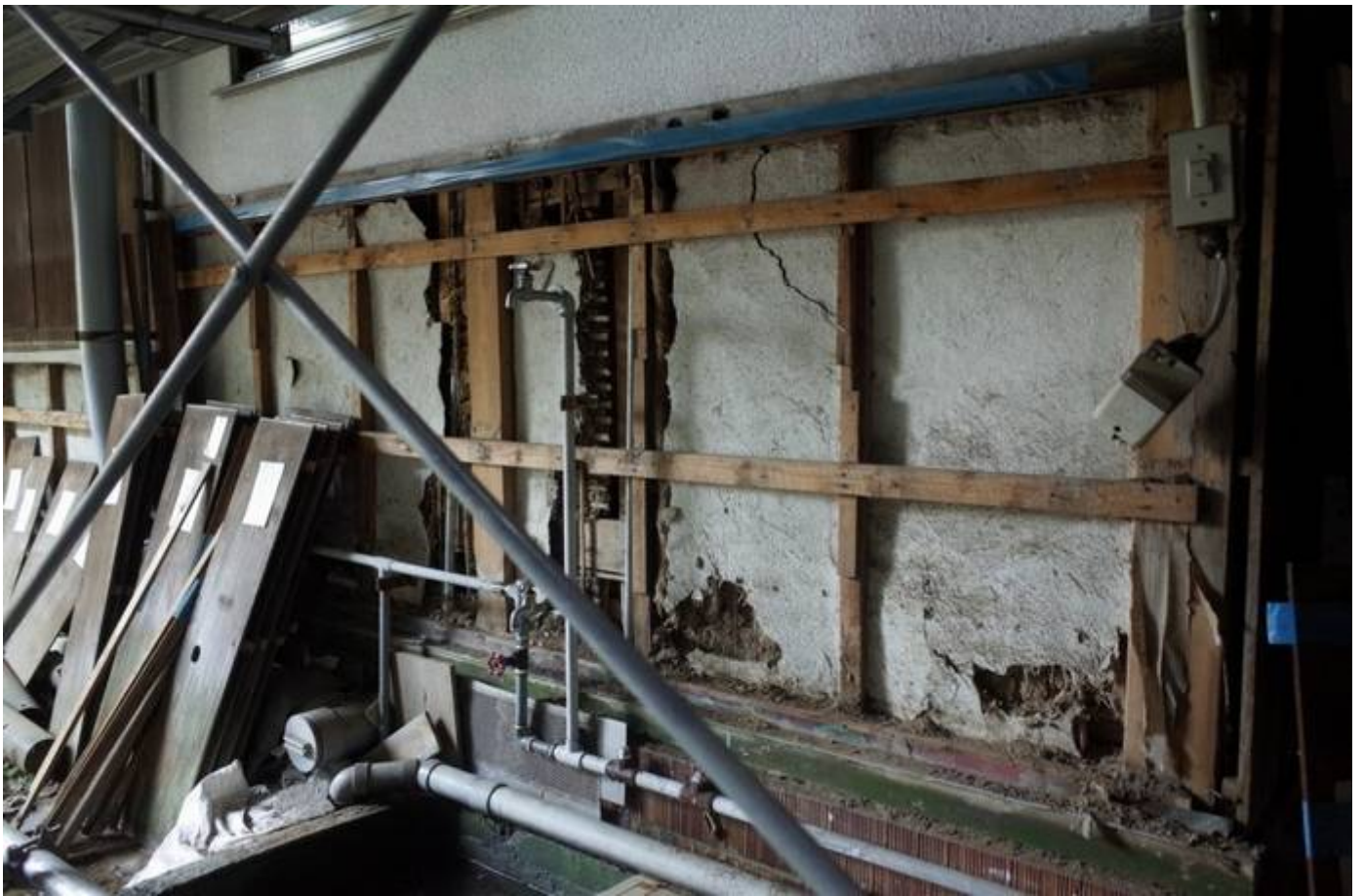
壁板の解体の様子です。 写真は、上屋一階台所の北面です。 配管などにより内部の土壁（表面は砂漆喰塗）が破損しています。
