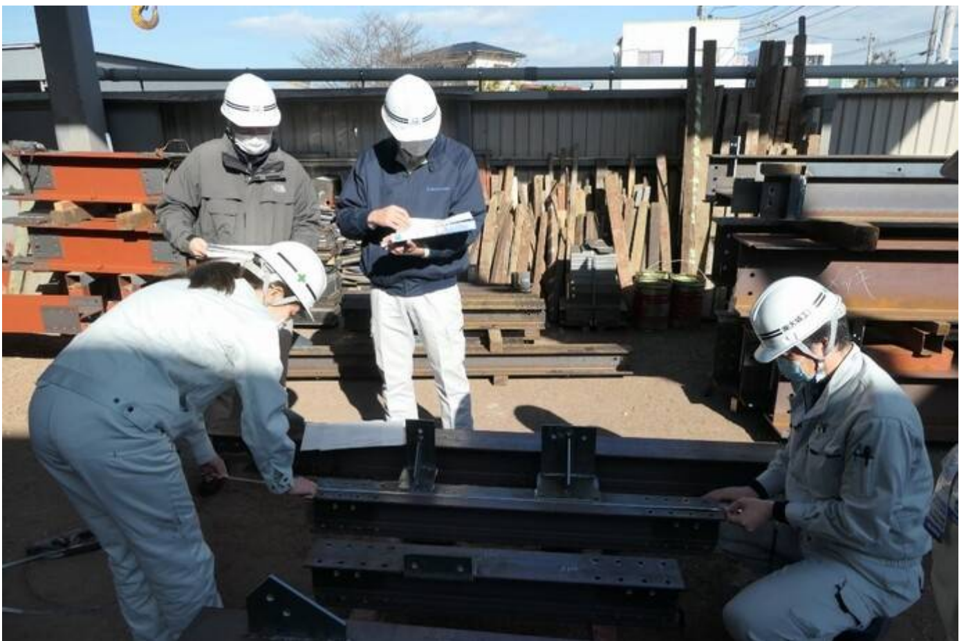
附上屋 耐震補強工事 鉄骨検査 寸法確認
