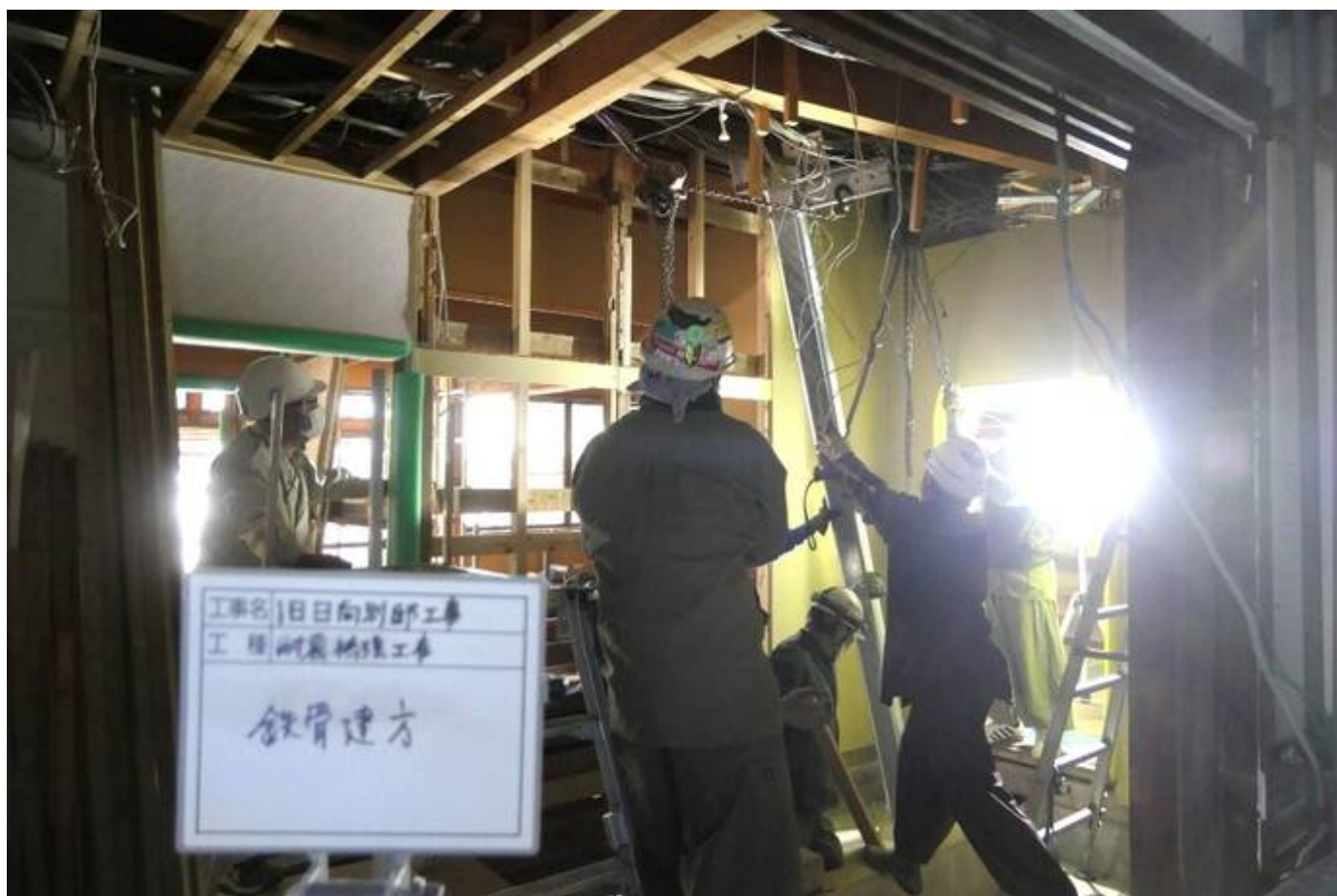
附上屋 耐震補強工事 鉄管柱建方 台所部分
