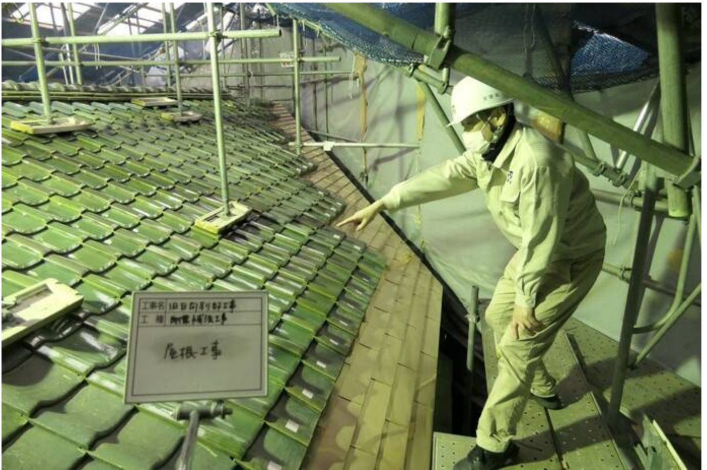
附上屋 屋根工事 瓦葺き確認
