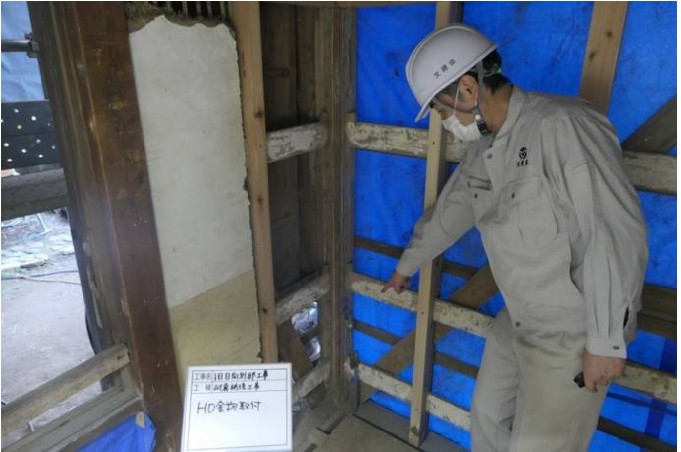
上屋1階 道側の基礎部分 ホールダウン金物確認です。
