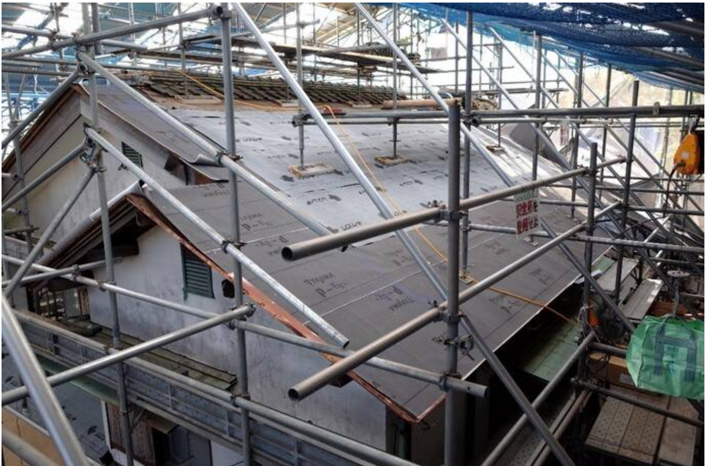
ルーフィング張りをしています。
