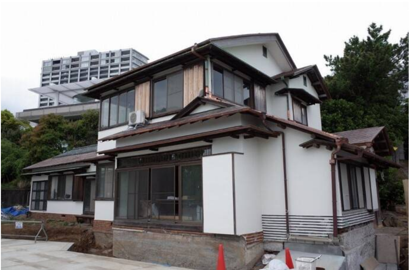
附上屋 仮設工事 素屋根解体完了。
