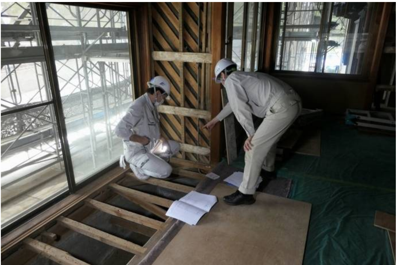
壁板の解体の様子です。 写真は、上屋一階台所の北面です。 配管などにより内部の土壁（表面は砂漆喰塗）が破損しています。
