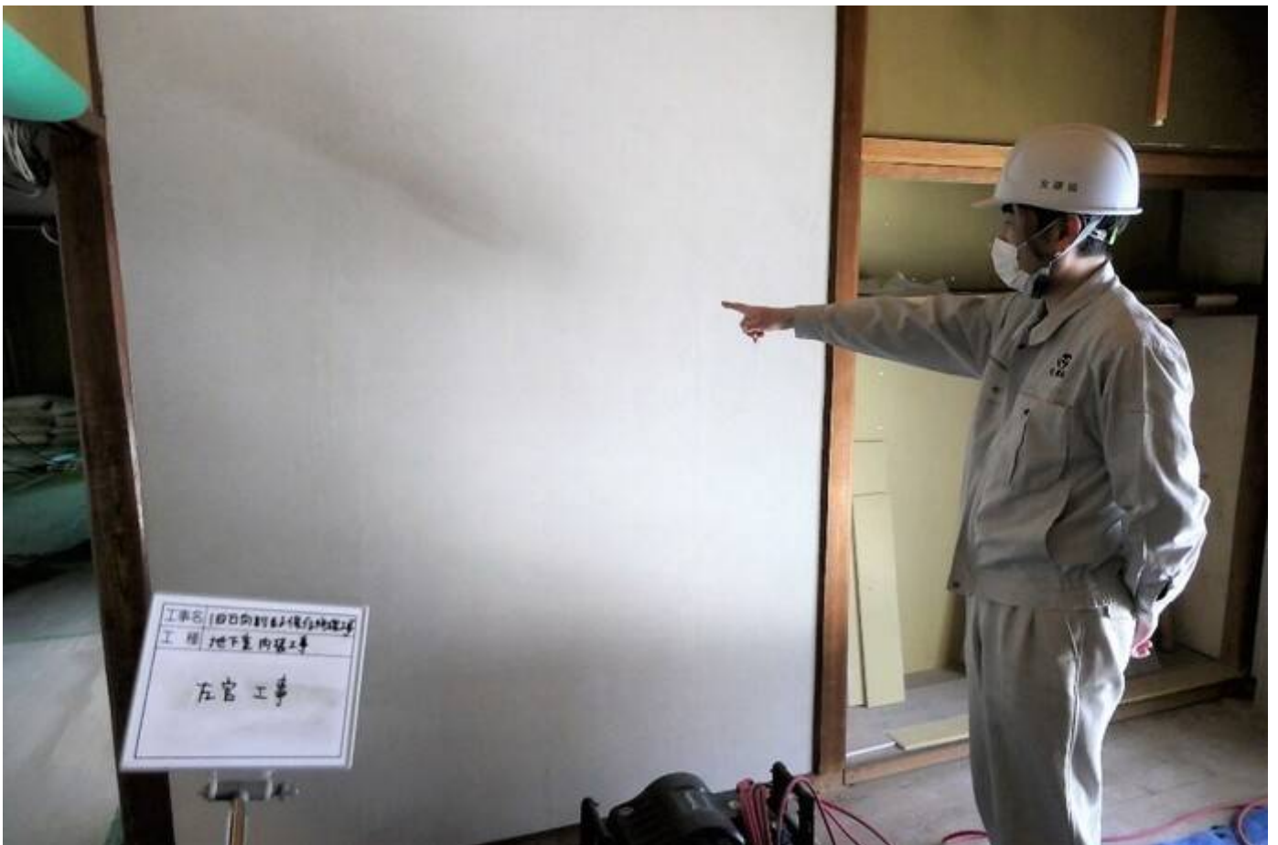
附上屋 左官工事 耐震補強壁部分 下塗り確認 この上に現状と同様のじゅらく調仕上げ塗りを行いました。
